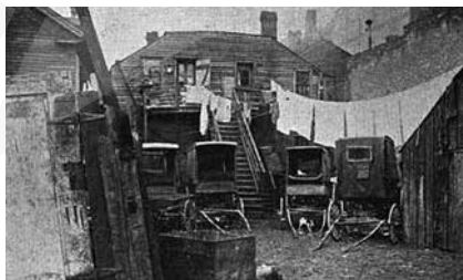
Fotografía 1.2. Jefferson Street. En el cobertizo de la derecha hay tres caballos. En el siguiente, seis caballos y dos cabras. En la casa del centro, sin ningún elemento positivo, viven varias familias italianas. A la izquierda, otras casas llenas de familias (1911).
