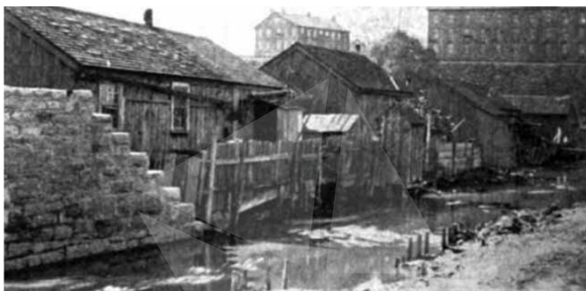
Fotografía 1.1. Siracusa, en el estado de Nueva York. Chabolas sobre una alcantarilla abierta.
